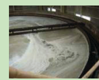
水溶性蛋白の凝集加圧浮上
