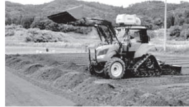
A機 (集土作業)
