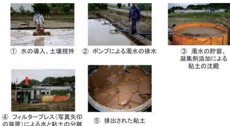
図2 土壌攪拌-吸引排水法による浄化工程
